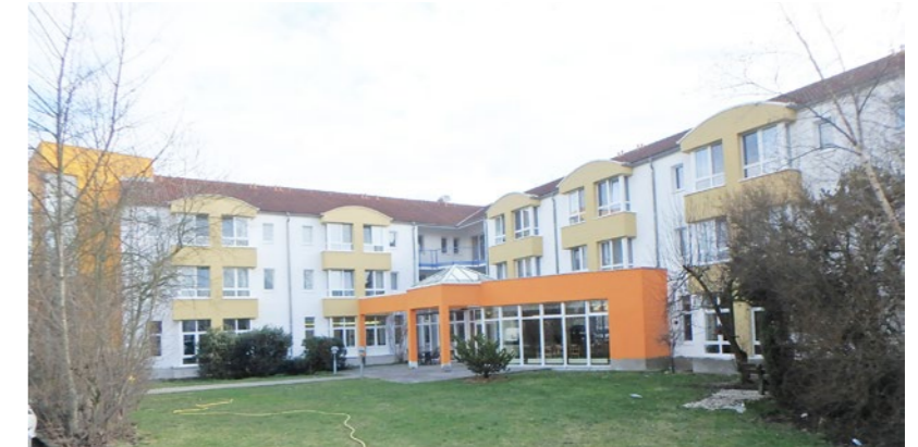
Die Fassade nach Abschluss der Sanierung
