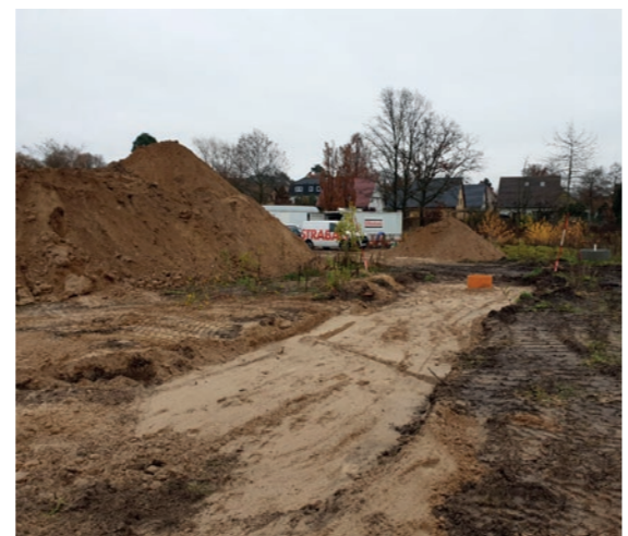
In Berlin-Mahlsdorf errichtet das EDBTL ein Altenhilfeszentrum (s. S. 46)
