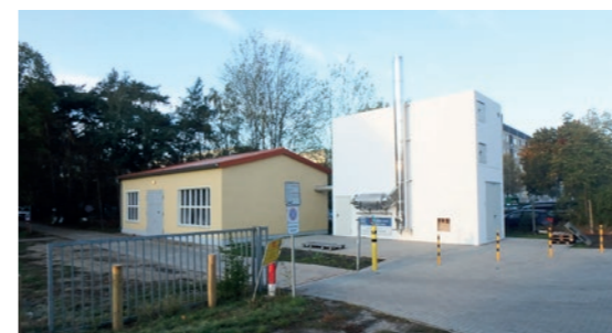
Heizhaus am Evangelischen Krankenhaus Ludwigsfelde-Teltow. Die Wärmeversorgung erfolgt umweltfreundlich über Holzpellets.
