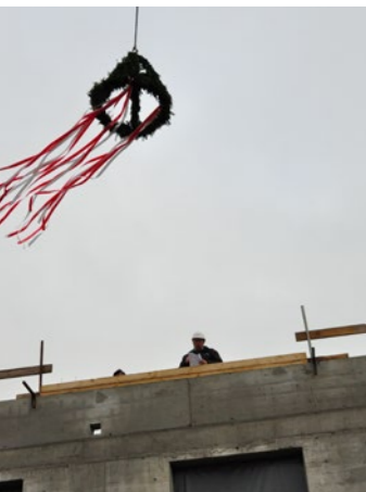
18. Dezember 2014: Die Richtkrone schwebt über dem Rohbau
