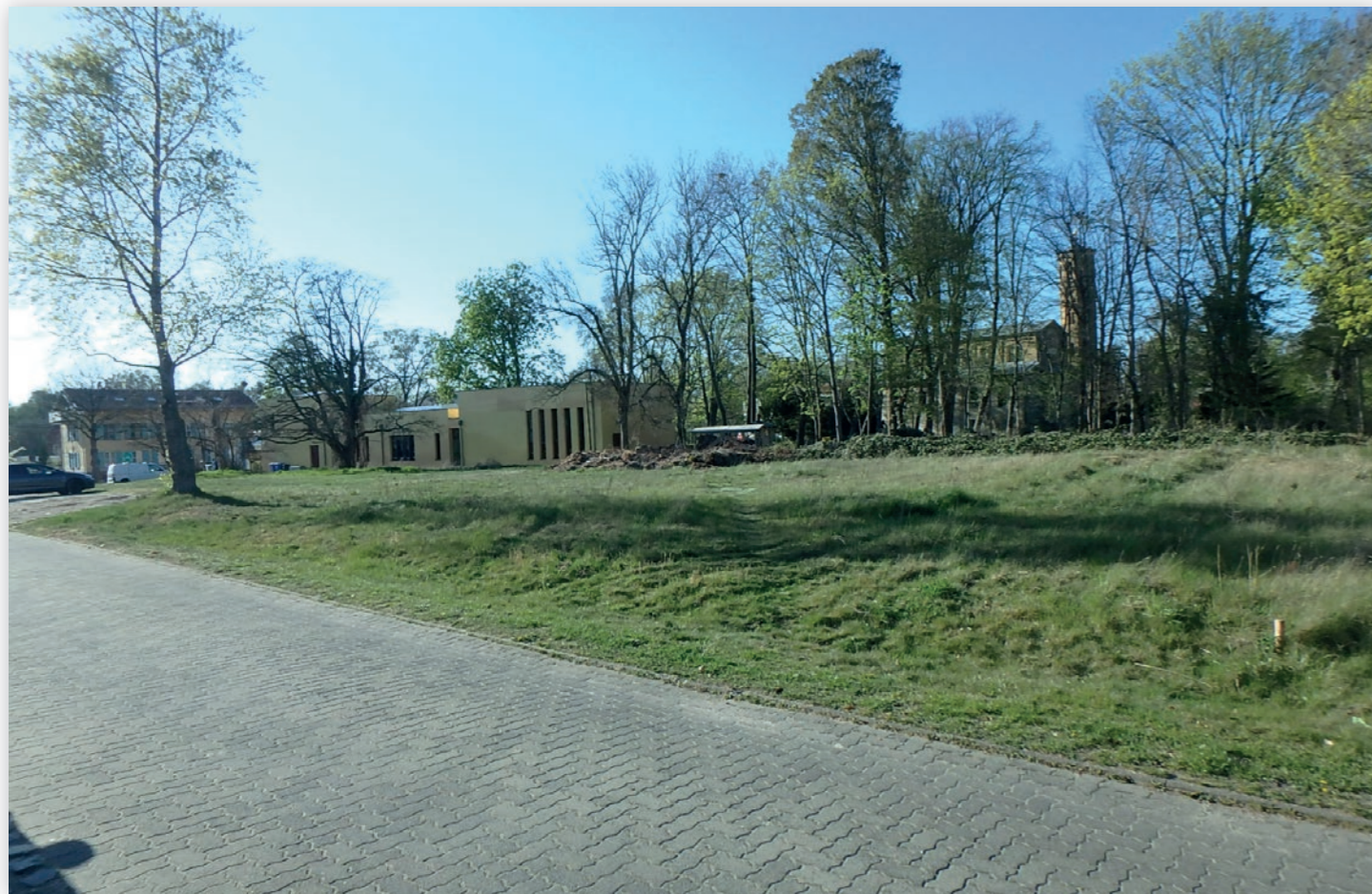
Hier entsteht die neue Kita
